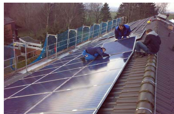
Installation der Solarmodule Dez. 08
