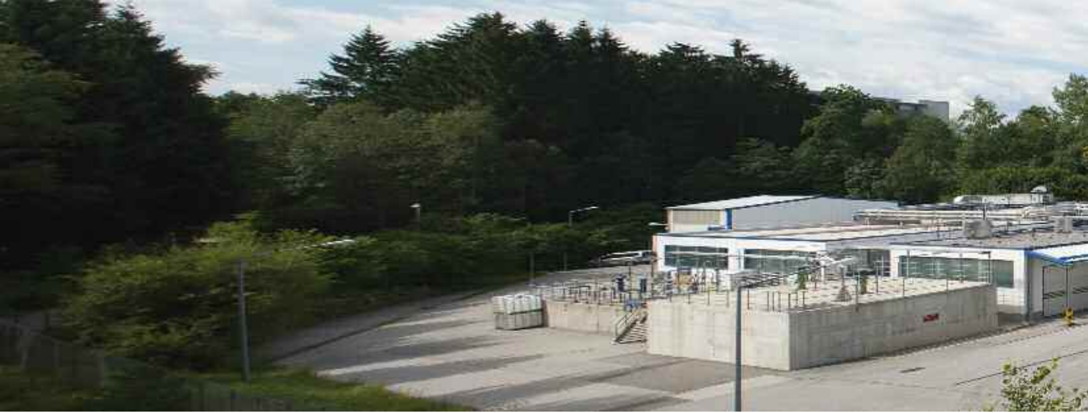
▲ Abwasserreinigungsanlage und BHKW (Foto: Hoffmann)
